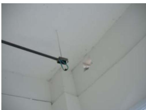
Ponto de força 220 V - infraestrutura para instalação das unidades evaporadoras (UE)
