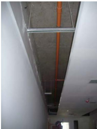
Guias metálicas (suportes) passando pelo entreforro da circulação dos pavimentos tipo para instalação da tubulação frigorígena (da Sala Técnica até os conjuntos)
