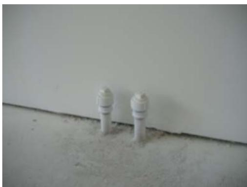
Drenos no piso do conjunto – infraestrutura para instalação das unidades evaporadoras (UE)
